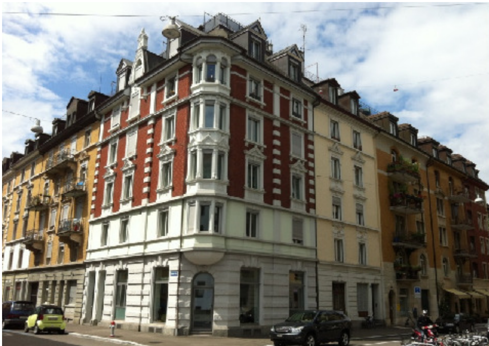
Anwandstr. 44, 8004 Zürich (erbaut ca. 1900)
